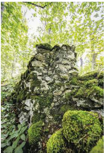
Bald drohen die letzten Mauern einzustürzen – ein Rest auf dem obersten Grat des Hohengenkingen
